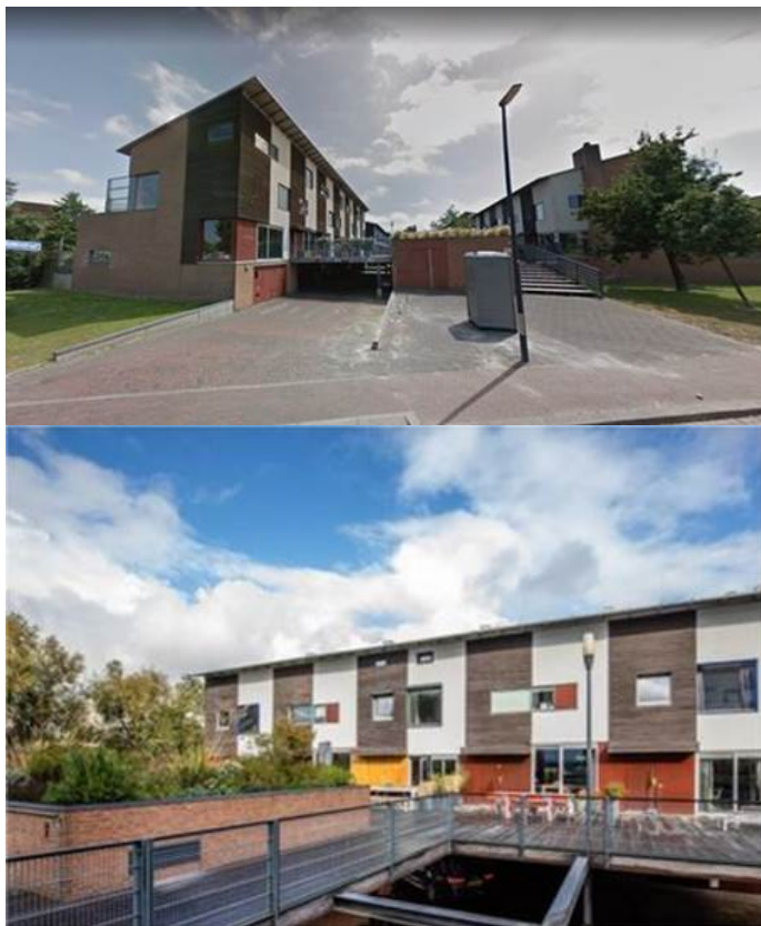
Willy den Oudenstraat in Rotterdam. De auto's en fietsen staan beneden. Leef- en speelruimte buiten op de vlinder. Mooi voorbeeld van verdichting door dubbel ruimte gebruik.
