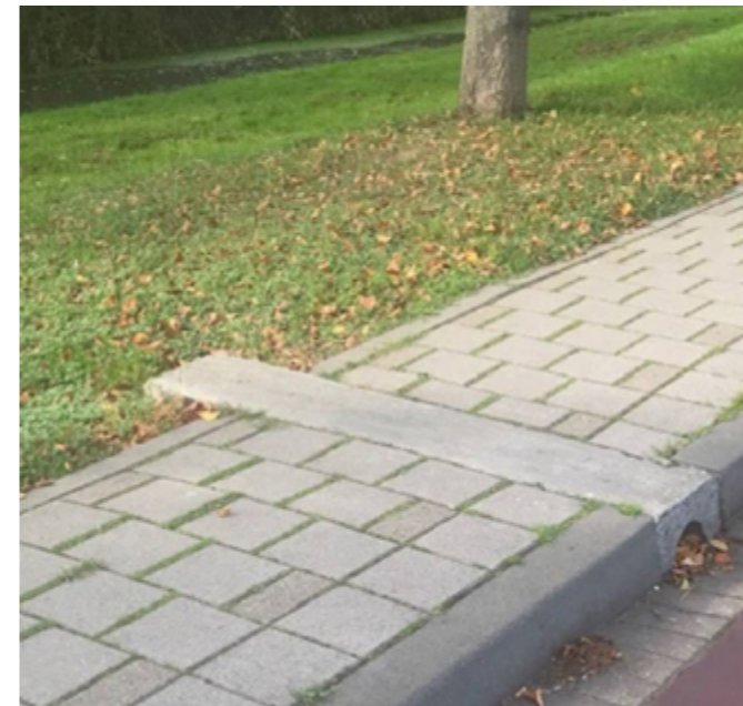
Betonkoker profiel voor oppervlakkig afvoeren van regenwater dat op de straat valt naar plekken waar het op een natuurlijke manier in de bodem kan trekken.
