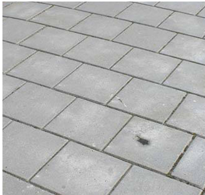
Trottoir: betontegels 30x30 - alternatief biobased variant
