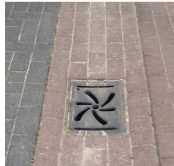
Infiltratiekolk toepassen op de plekken waar het regenwater wordt afgekoppeld van het gemengde riool en wordt afgevoerd naar het oppervlakte water
