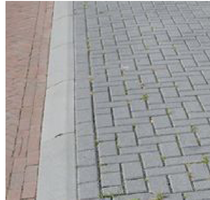
Verhoogde parkeervakken voor versmalling van de rijbaan (snelheidsremmend) en verbreden van het trottoir
