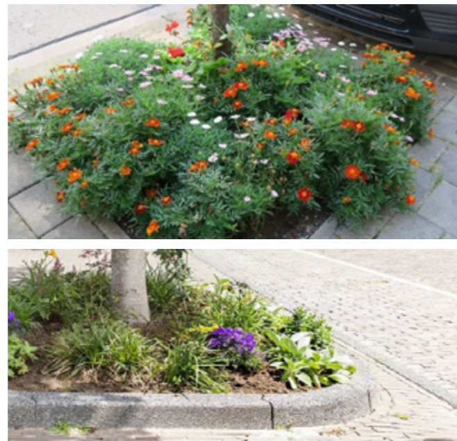
Bomen beschermen met bijvoorbeeld een verhoogde betonband en/of begroeide boomspegel. Hierbij is ook aandacht gevraagd voor de afvoer van hemelwater.
